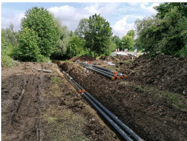
Budowa sieci preizolowanej w okolicach ulic Giewont i Żyznej
