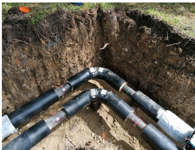
Roboty montażowe sieci ciepłowniczej w okolicach ulic Giewont i Żyznej
